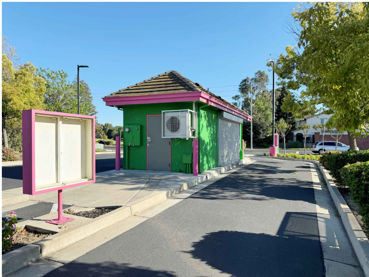
EXISTING PHOTO @ DRIVE THRU SCALE: N.T.S
