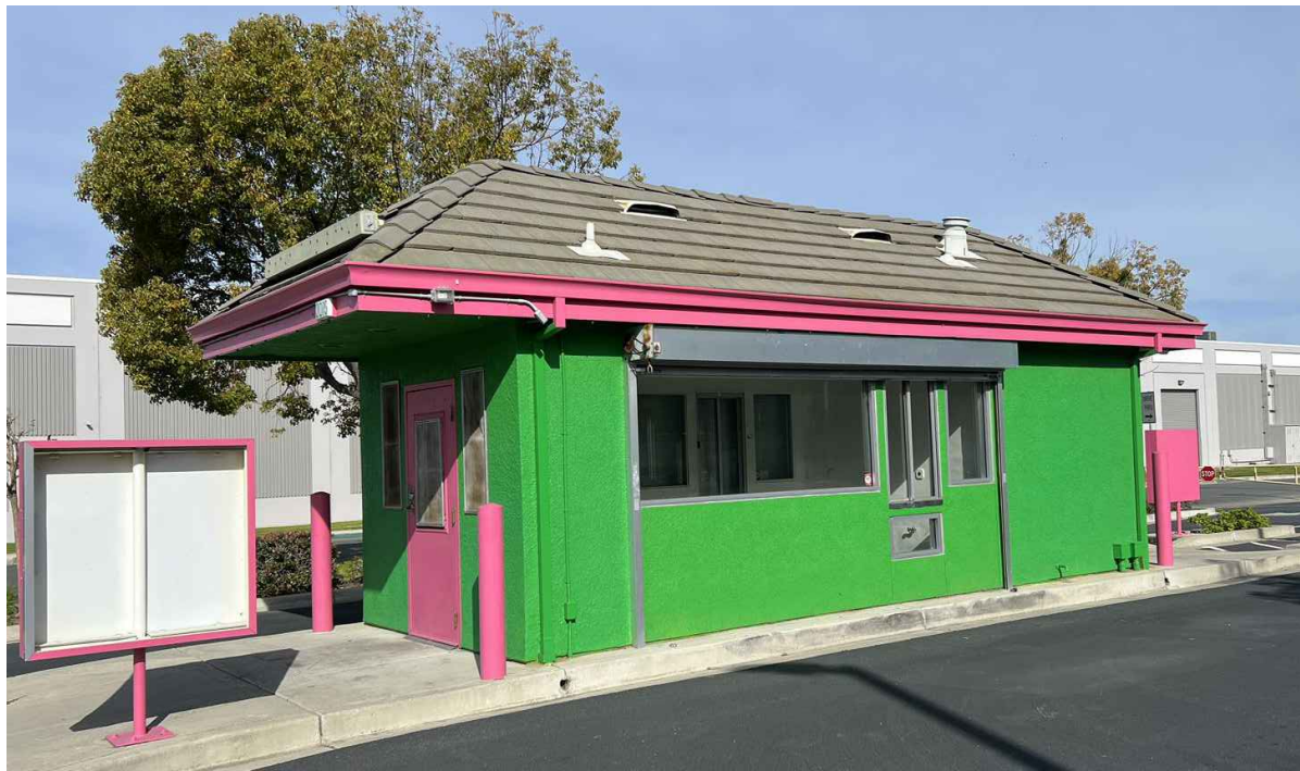
EXISTING PHOTO @ FRONT ENTRANCE SCALE: N.T.S
